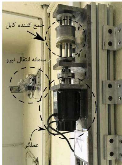
شکل ۳) سامانه کابل جمع‌کن و عملگر
